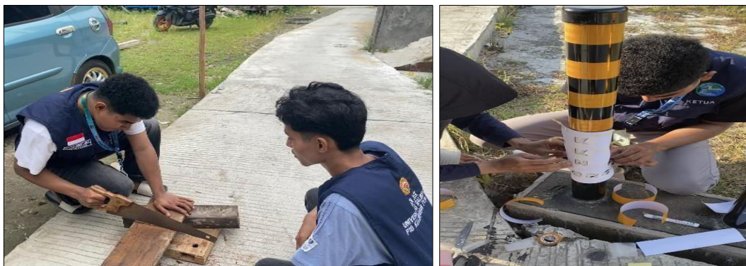
Gambar 3. Pembuatan dan Pemasangan Delineator.
