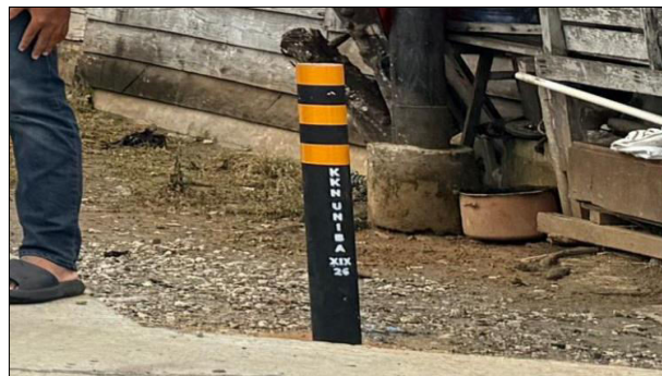
Gambar 4. Salah Satu Hasil Pemasangan Reflektor Jalan.
