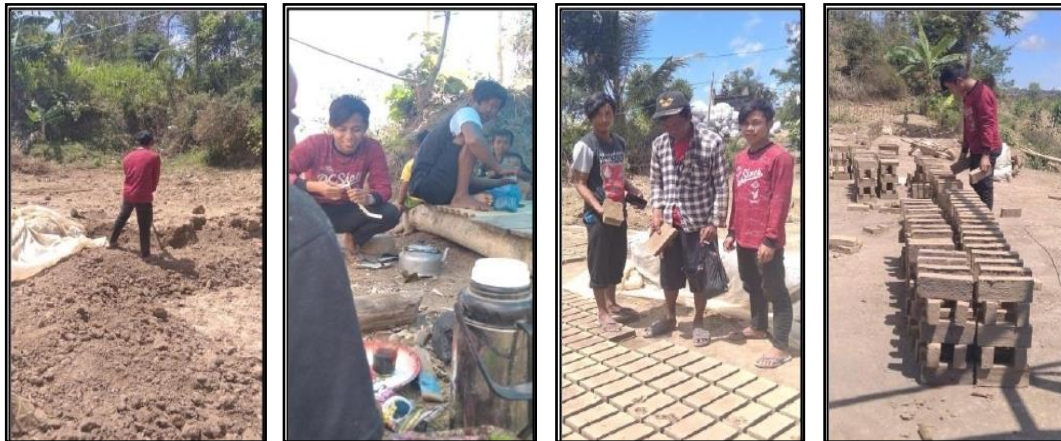
Gambar 1-4. Proses Pembuatan Batu Bata Merah di Dusun Kuwur Numpuk, Desa Montong Sapah, Kabupaten Lombok Tengah.
