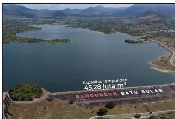
Gambar 1. Bendungan Batu Bulan.
